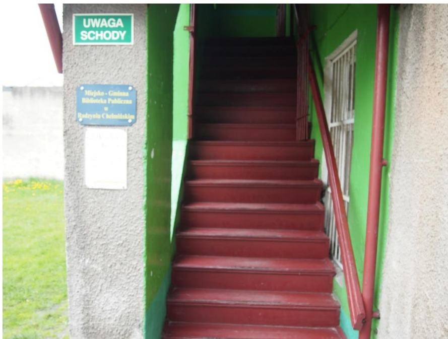
Zdjęcie 1. Budynek, w którym mieści się Miejsko-Gminna Biblioteka Publiczna
