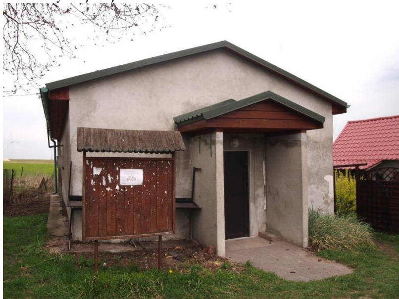
Zdjęcie 6. Budynek świetlicy wiejskiej w Gawłowicach
